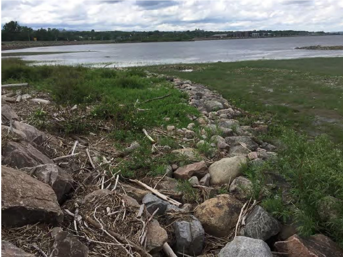
Photo 1: Enrochement permettant de stabiliser le sol reprofilé (Houde, 2017).
